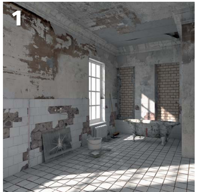
État avant rénovation
